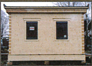
Gebäude mit Außenwänden in Massivblockbauweise
